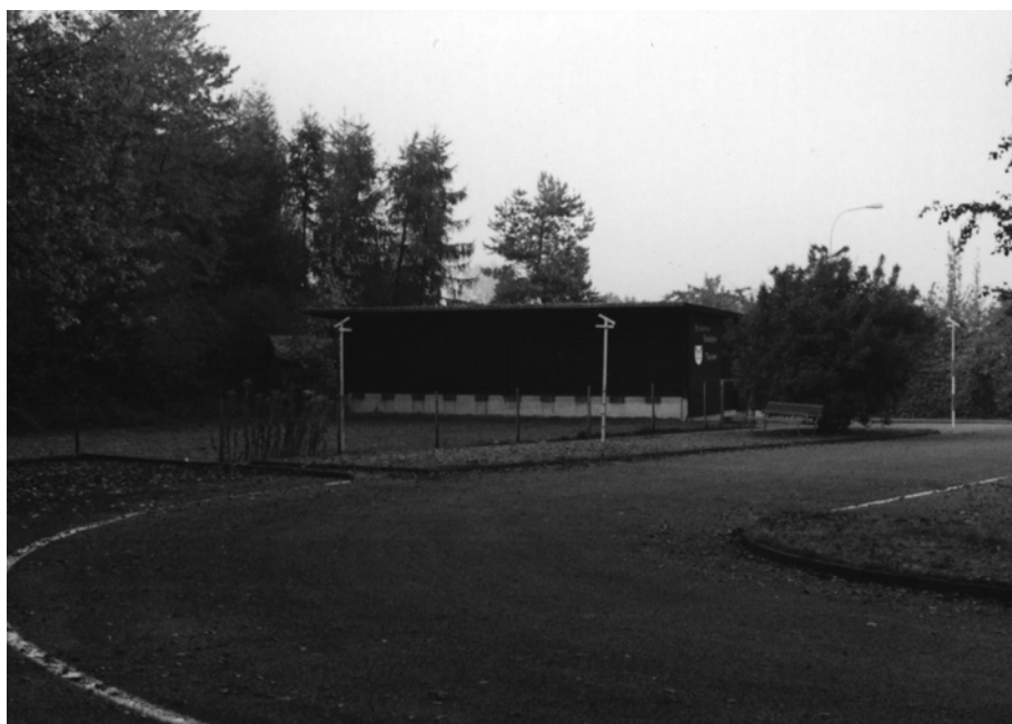
Das Baugespann ist erstellt
